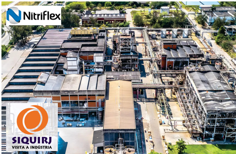
Planta da Nitriflex, no Polo Industrial de Duque de Caxias, Polo Petroquímico de Campos Elísios
